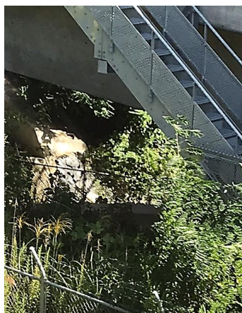
(上黒駒の地下水噴出は続く)
