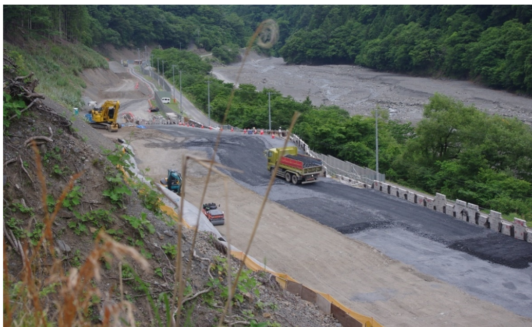
図１８ 山梨県早川町赤沢における発生土処理（２０２１年６月頃原告川村晃生撮影）
