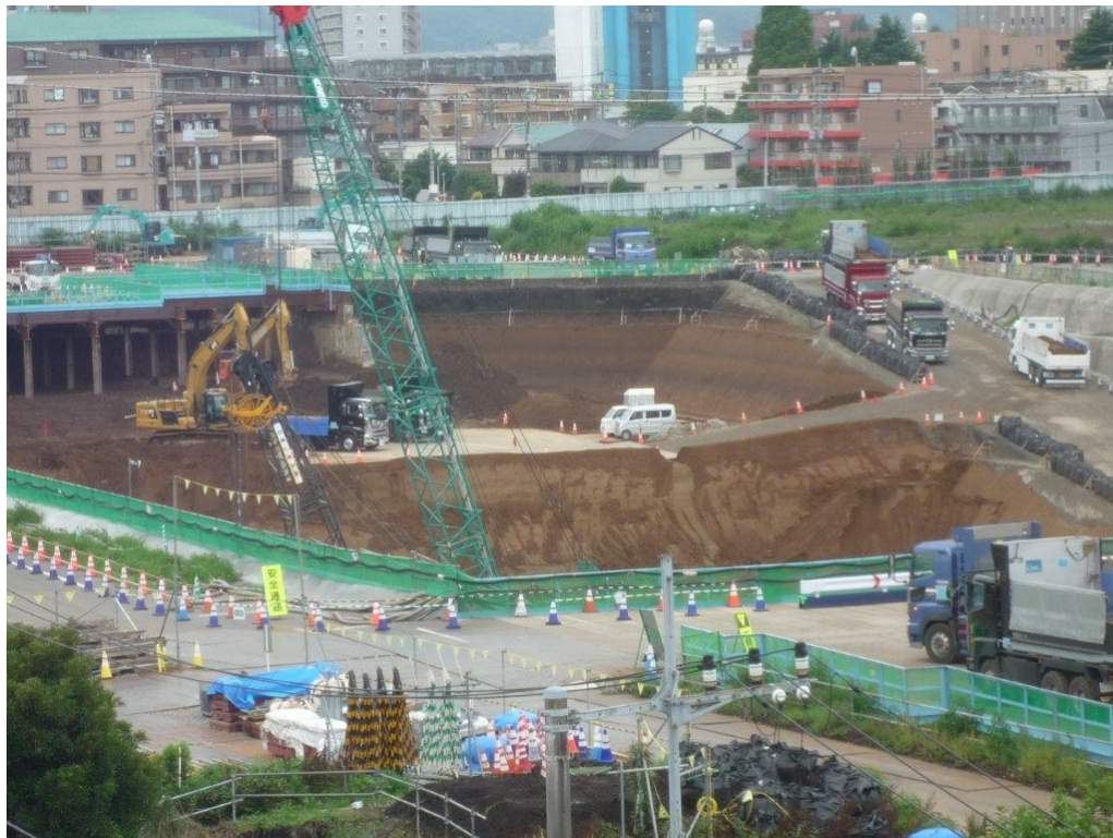
図4 神奈川県駅予定地の工事の様子（2021年7月7日原告撮影）
