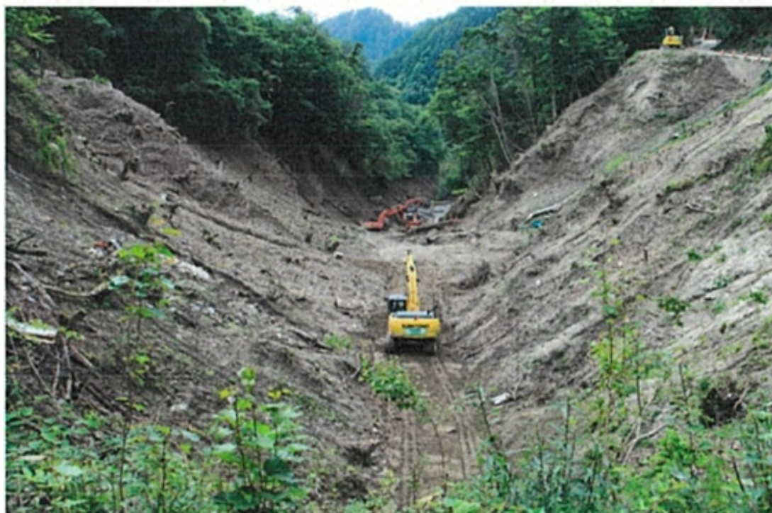
図12 ジンガ洞の工事現場（甲CN第27号証の㊸）
