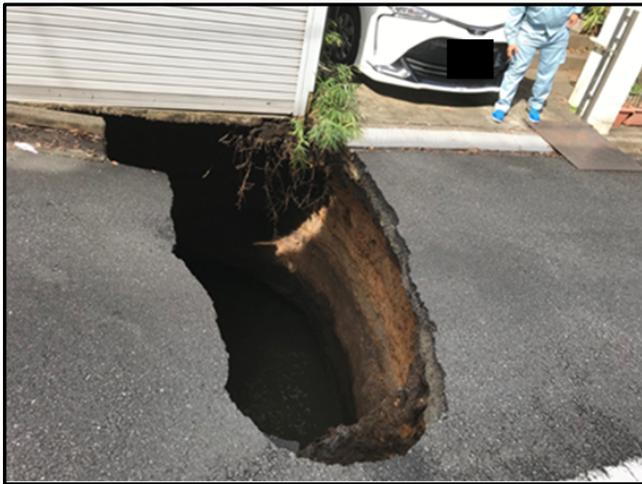
事前に予告も説明もなし、シールドトンネル掘削が進んでいた9月中旬頃、騒音・振動で建物が震度2の揺れ、ブロック塀にひび割れ、玄関戸口が沈む、外の階段に亀裂、マンホールのふたや側溝の周囲に砂が噴き出た(液状化)。住民からの苦情が100件以上寄せられても、ネクスコ東日本は対応もしない状況で10月18日には住宅地で陥没がおきた。周辺の調査で、地下深さ5m長さ30m幅4mで空洞が2か所見つかる。
