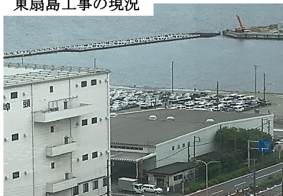
東扇島工事の現況
