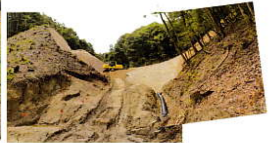
写真③ 土留擁壁(1) 掘削作業状況
