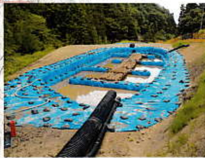
写真② 仮設沈砂池
