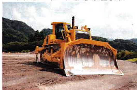
ブルドーザーによる転圧状況
