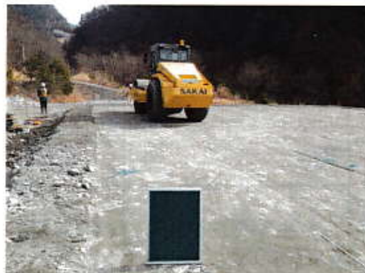
他工事での試験盛土の実施例
