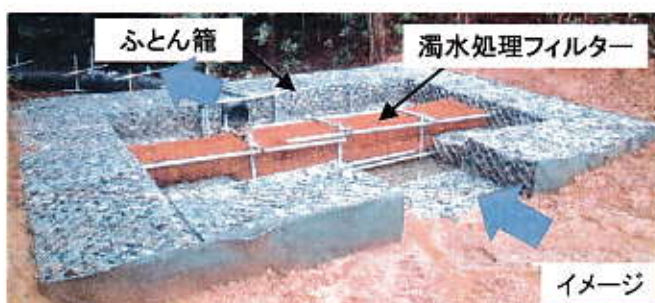
仮設沈砂池設置例
