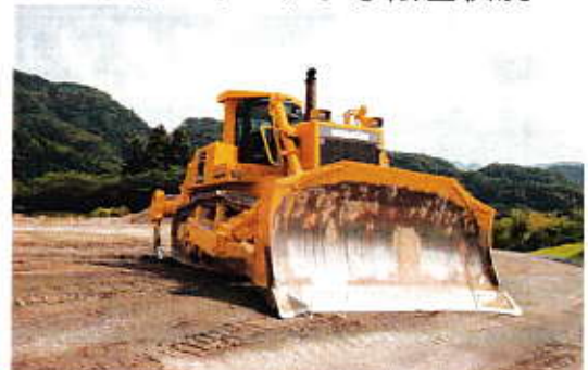
ブルドーザーによる転圧状況
