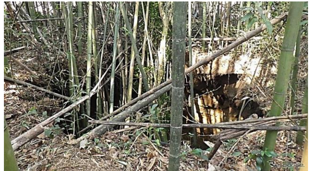
岐阜県・リニア山口工区落盤事故
